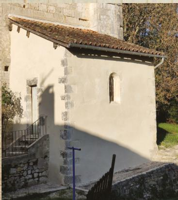
Prévus depuis de nombreuses années, les travaux de ravalement de façade de la sacristie viennent d'être réalisés. Ces travaux s'avéraient nécessaires en raison de la présence de nombreuses lézardes susceptibles de fragiliser la structure du bâtiment. L'édifice a retrouvé son lustre d'antan. Des travaux intérieurs pourraient être utilement réalisés en 2025, notamment par la réfection du sol qui s'avère dangereux pour les utilisateurs.
